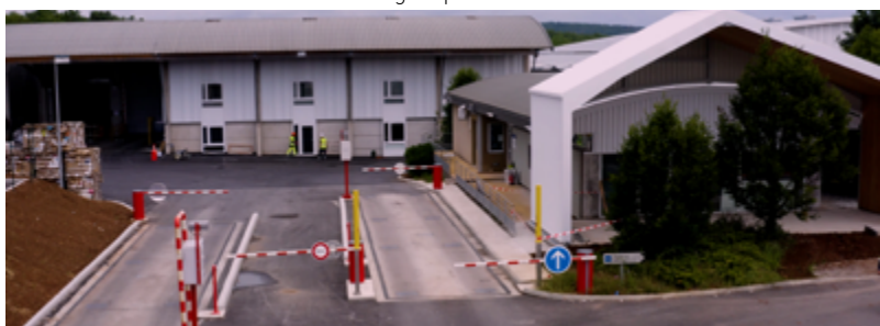
Entrée du centre de tri - pont bascule pour la pesée des camions entrants et sortants ©Astragale production
